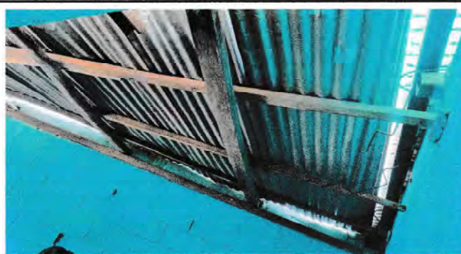
Foto 2: Sustrucción de estructura (madera, metal) por metal
