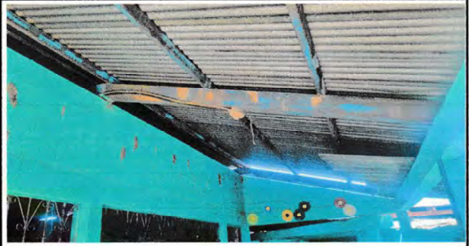
Foto 2: Sustrucción de estructura (madera, metal) por metal
