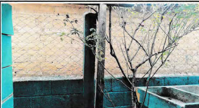
Foto 3: Reparación de perimetral de block
