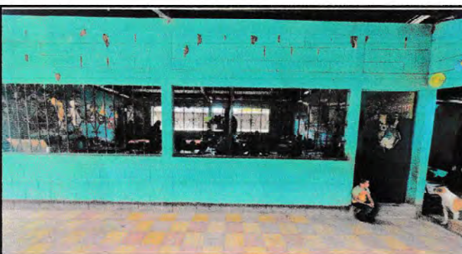
Foto 5: Pintura de muros exteriores e interiores
