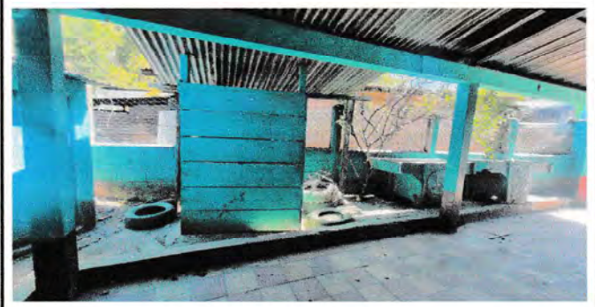
Foto 3: Reparación de perimetral de block
