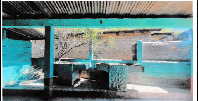
Foto 4: Reparación de perimetral de block
