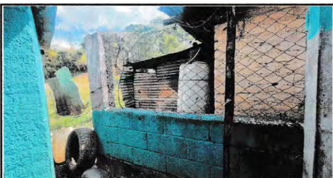
Foto 3: Reparación de perimetral de block
