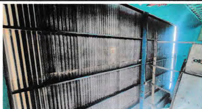
Foto 2: Sustrucción de estructura (madera, metal) por metal
