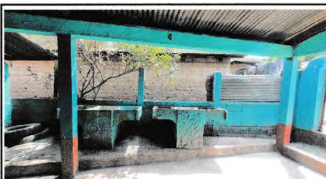
Foto 4: Reparación de perimetral de block
