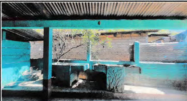
Foto 4: Reparación de perimetral de block
